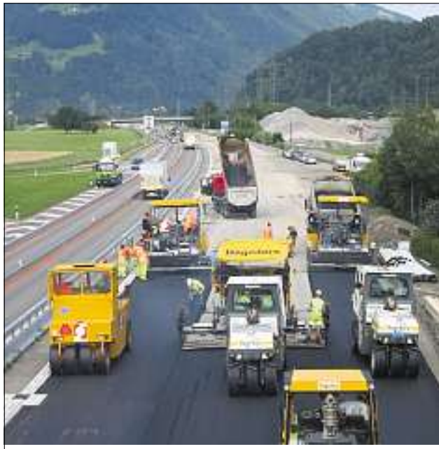
Einbau des lärmarmen Deckbelags: schafft für die Strassenbenutzer ein angenehmeres Fahrgefühl und verhindert Immissionen in die Umgebung.
