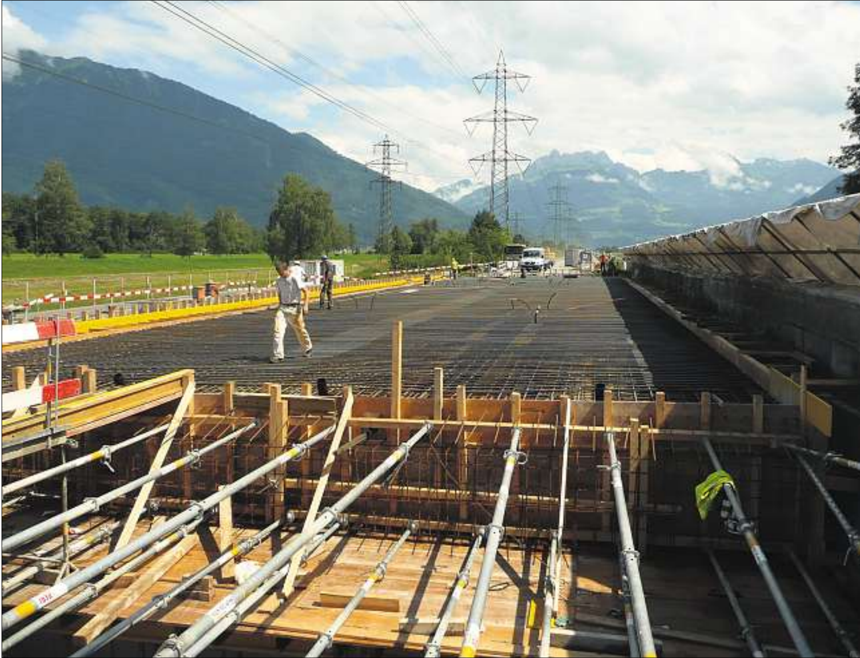
Neuer Wildtierkorridor Hängelgiessen: Die Brücken für das Projekt Wildtierkorridor A3 werden als Verkehrsträger genutzt. Sie unterbrechen den Damm, auf welchem die A3 Linthebenestrassen parallel zum Linthkanal geführt wird, und dienen dadurch als Wildtierkorridor (zwischen Linthkanal und der auf der linken Seite der Linth und der A3 gelegenen Auenlandschaft). Im Rahmen des speziellen Hochwasserschutzkonzepts lässt sich das «Dreieckswäldli» zusätzlich als Ausgleichsfläche nutzen.
