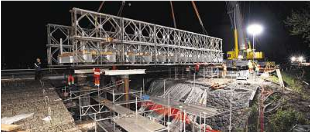
SBB-Brücke Glarnerlinie bei Niederurnen: Spektakulärer Einbau der Hilfsbrücke während der Nacht.
