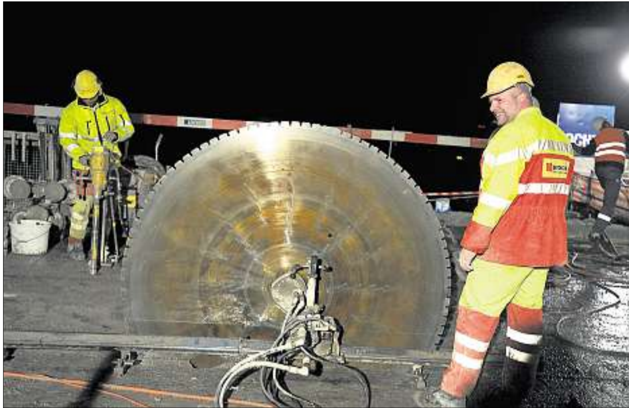
Die Diamantbohrschleifen fressen sich durch den über 50 Zentimeter dicken Beton. (Kurt Kassel)
