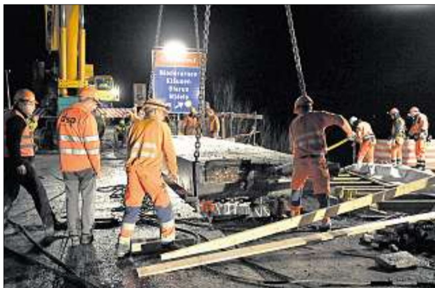
Die über 30 Tonnen schweren alten Brückenelemente wurden emporgehievt.
